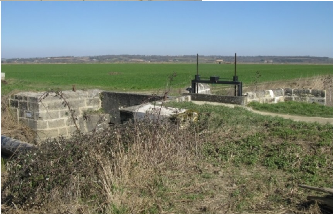
Chenal et porte éclusière du Port de Charron, canal de Charron - La porte de Charron vue depuis le sud-ouest, en aval.
