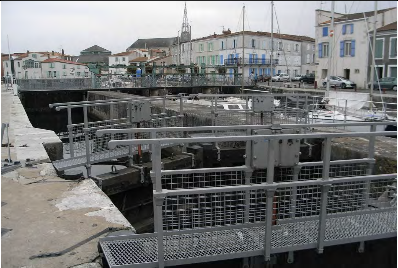
Barrage éclusé du carreau d'Or à Marans Source : https://fr.wikipedia.org/
