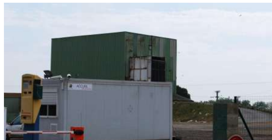
Photographie : Quai de transfert d'Agde
